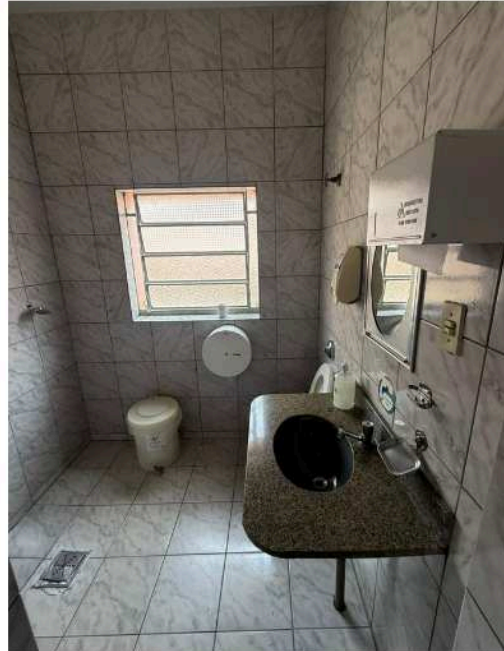
Banheiro dos funcionários
